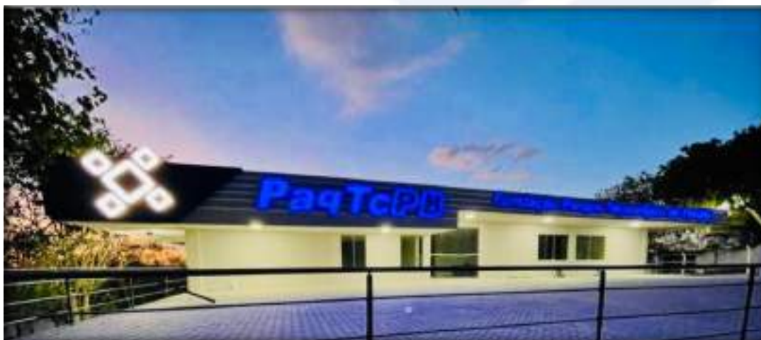
Figura 5 – Sede principal da Fundação PaqTcPB
