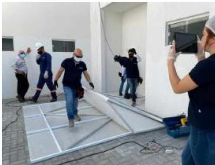
Foto 01: instalação da cabine no Hospital Pedro I em Campina Grande PB.
