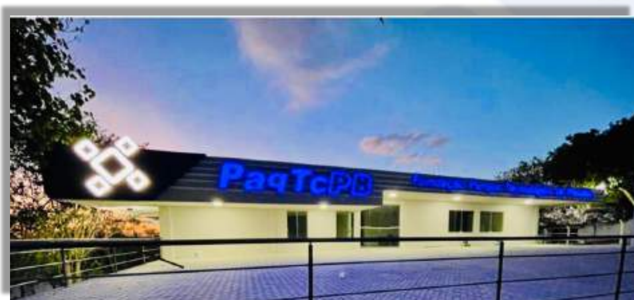
Figura 7 – Sede principal da Fundação PaqTcPB
